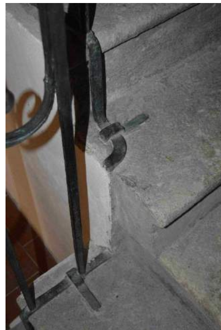
detail kotvení zábradlí
