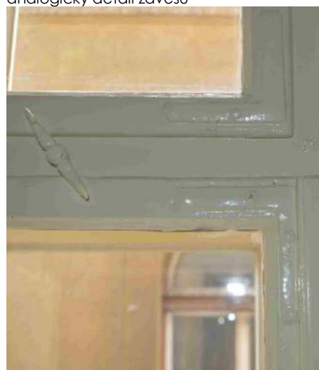
analogický detail zavírání s obrtlíkem
