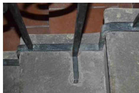
detail kotvení zábradlí do stupňů schodiště
