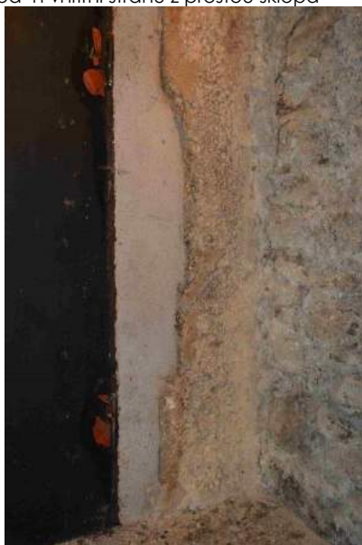
detail pravé stojky s dodatečným rozšířením profilu otvoru
