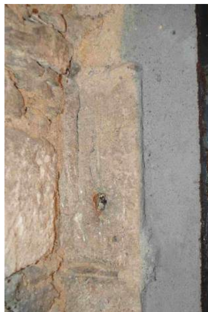
detail horní části s pravděpodobným výběhem obloukového nadpraží
