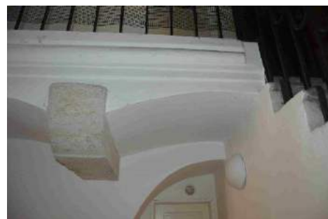
pohled na nosnou konstrukci pavlače s krakorcem
