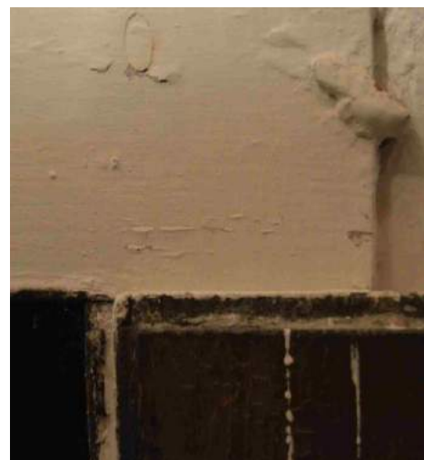
obložení s uchycením skobou
