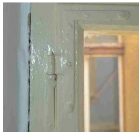
analogický detail závěsu
